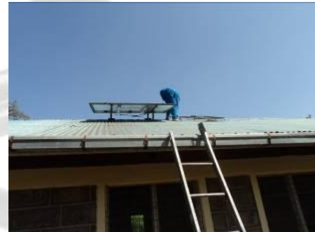
Instalación de las placas solares de la escuela
